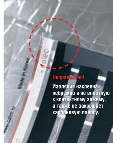
Рис. 13. Пример неправильной установки ПВХ изоляции
