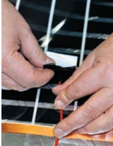
Рис. 23. Датчик прикрепляется к термоленке битумной изоляцией
