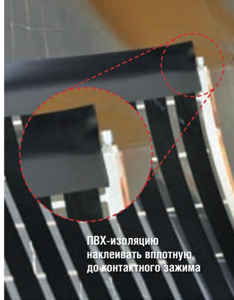
Рис. 11. Наклейка ПВХ изоляции на срез пленки
