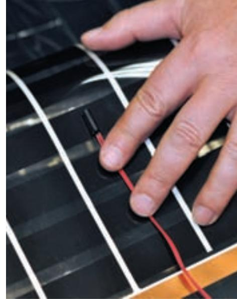
Рис. 21. Установка датчика температуры пола SF 4x15
