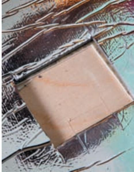
Рис. 22. Отверстие под датчик температуры пола в теплоотражающем материале
